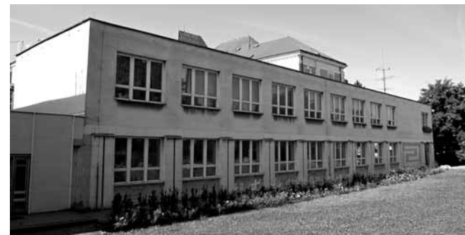
Budova knihovny v Ostravské ulici
