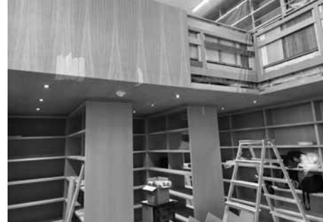
Momentka z období probíhající rekonstrukce
