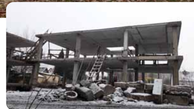
↑ Z původní budovy zůstaly pouze nosné prvky
