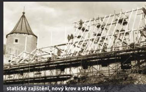
statické zajištění, nový krov a střecha
