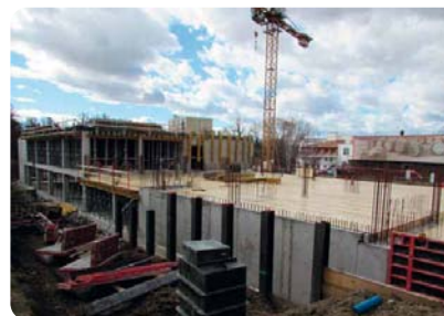
↑ Výstavba knihovny – stav z března 2019
