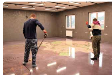
↑ Dokončovací práce na podlaze s mapou kraje
