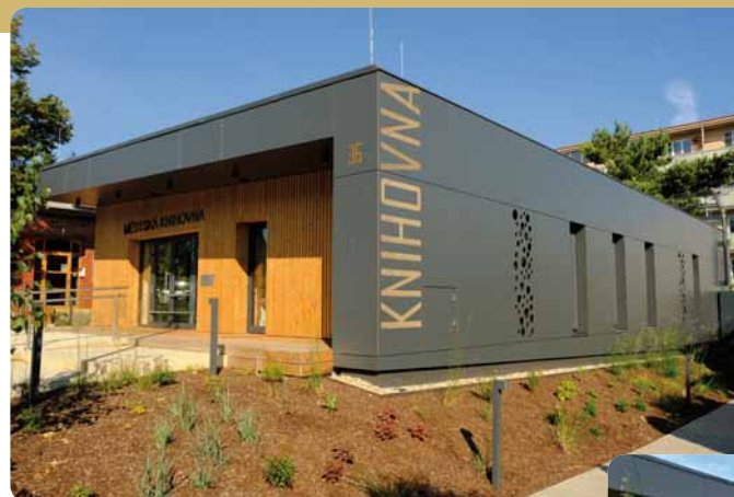
Nová budova pobočky Městské knihovny Chrudim v Topolské ulici s. 413–415 ← Pohled na novou budovu pobočky ze sídliště
