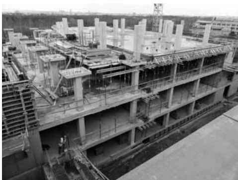
Výstavba nové budovy CDH
