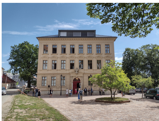
Objekt bývalé ZŠ J. A. Komenského v Kutné Hoře, dnes sídlo Knihovny Kutná Hora. Adresa: Na Náměti 416, Vnitřní Město, 284 01 Kutná Hora.
